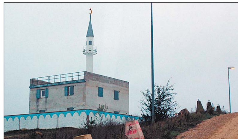
Dieses Gebäude, das einer Moschee nachempfunden worden ist, steht am Stadtrand von »Al Übungsdorf« in der Oberpfalz.
